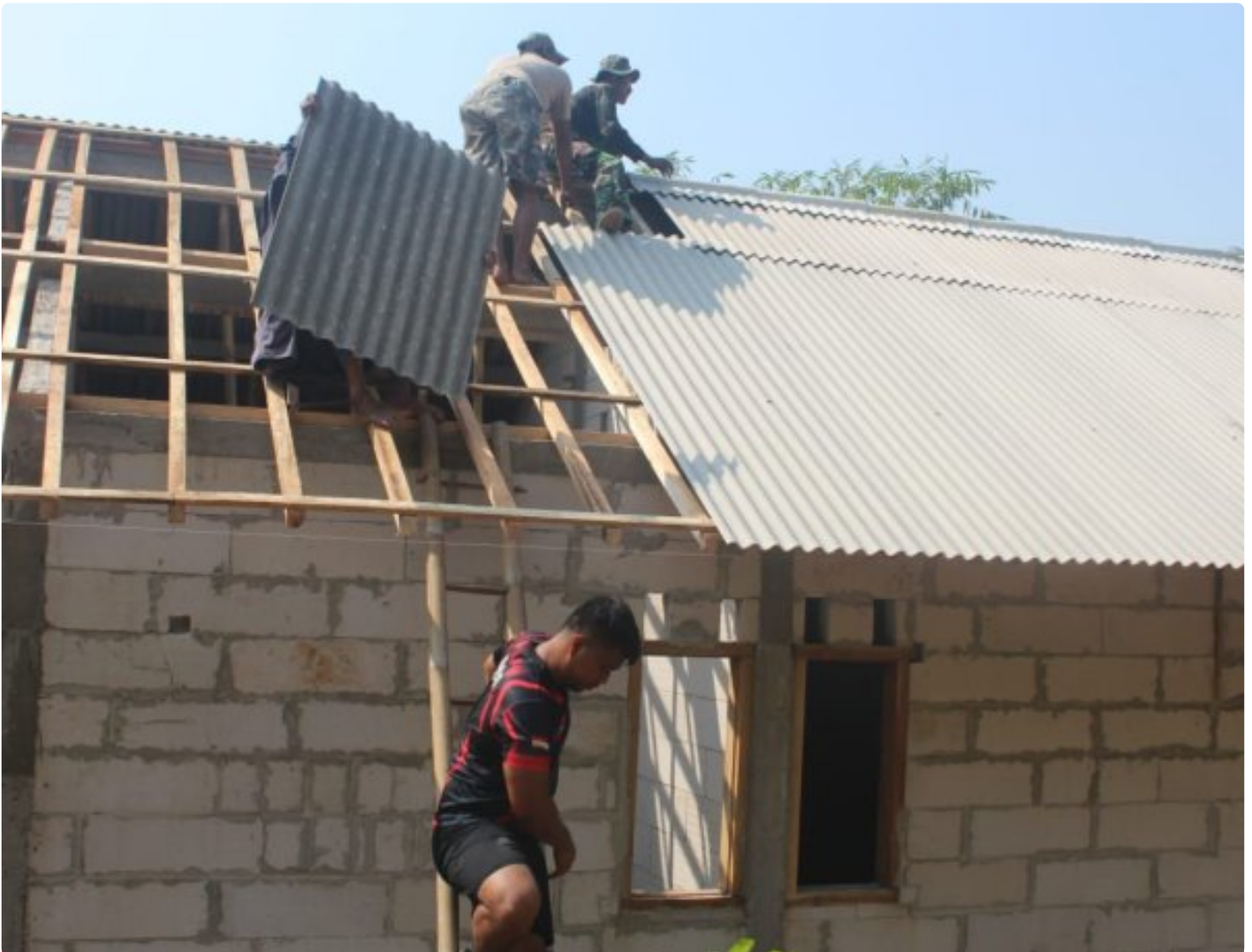
Pengerjaan RTLH Desa Pejengkolan Sudah Mulai Pemasangan Atap Rumah
