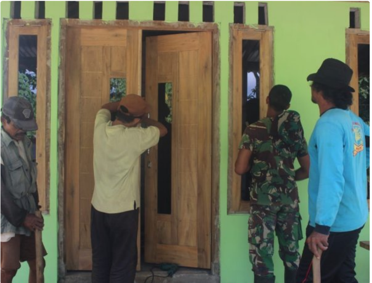
Kegiatan pemasangan daun pintu dan jendela rumah yang bertempat di Desa Pejengkolan
